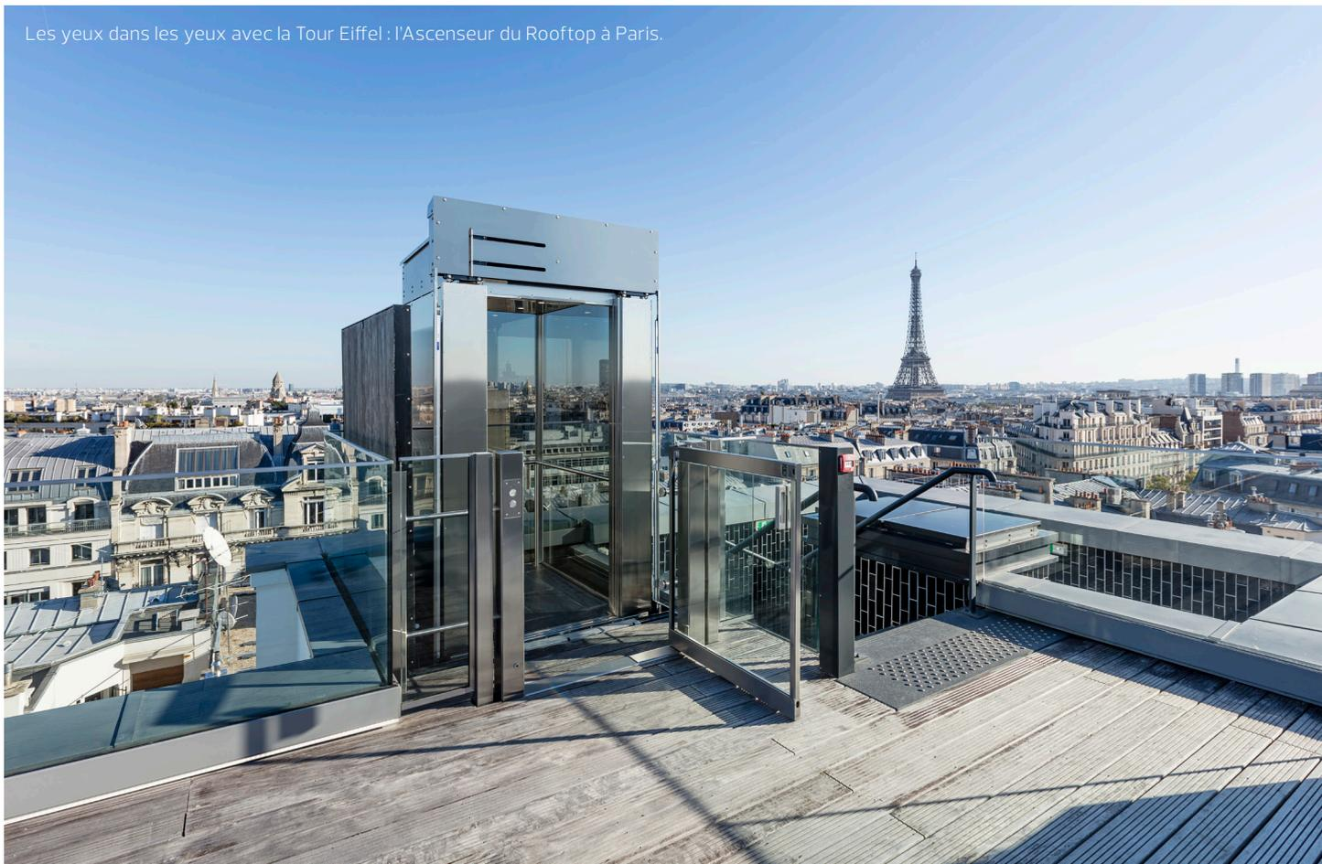
**Si l'ascenseur poursuit simplement son chemin à travers sa gaine, traverse la surface du toit et s'arrête en plein air, il s'agit alors d'un ascenseur pop-up. Conçu et réalisé par Emch.**
